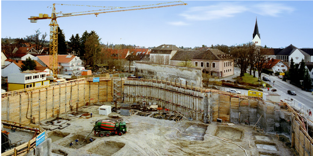
Wohn- und Geschäftshaus in Weilheim
